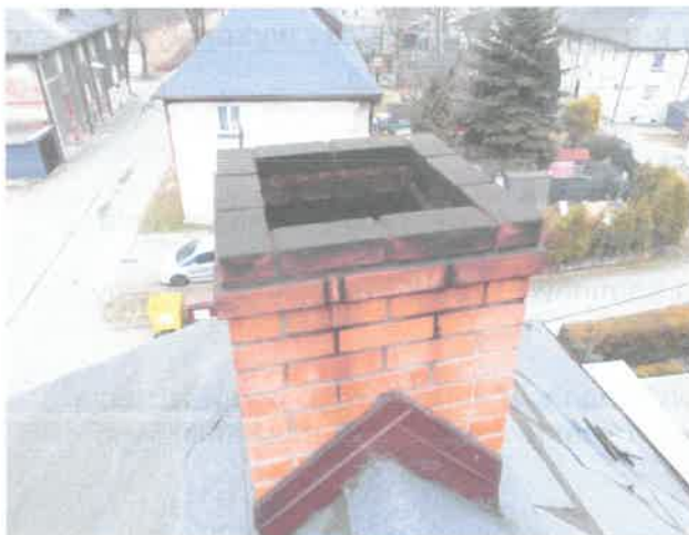
Komin ponad dachem w stanie bardzo dobrym
