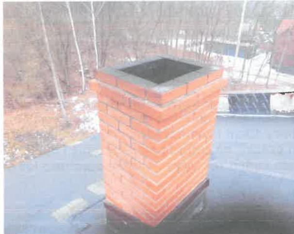
Komin ponad dachem w stanie bardzo dobrym
