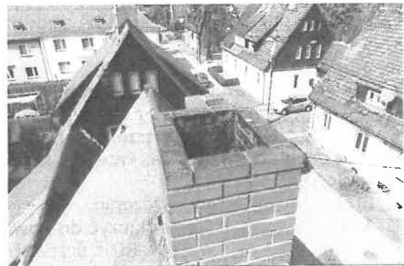
Komin ponad dachem w stanie bardzo dobrym
