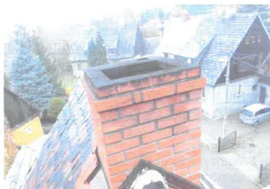
Komin ponad dachem stan bardzo dobry
