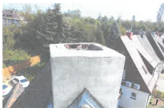
Komin ponad dachem w stanie poprawnym.
