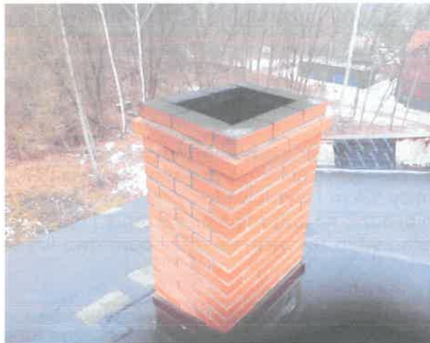
Komin ponad dachem w stanie bardzo dobrym
