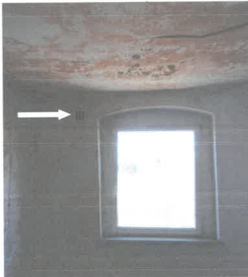
WK przez zewnętrzną ścianę budynku należy pozostawić
