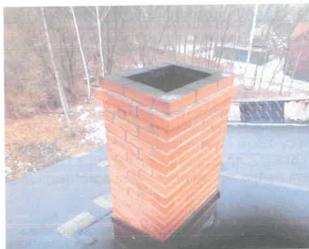
Komin ponad dachem w stanie bardzo dobrym
