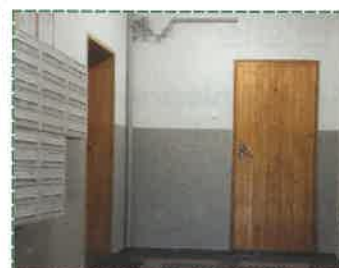
Klatka w budynku przy ul. Agrestowej 5 w Zabrzu
